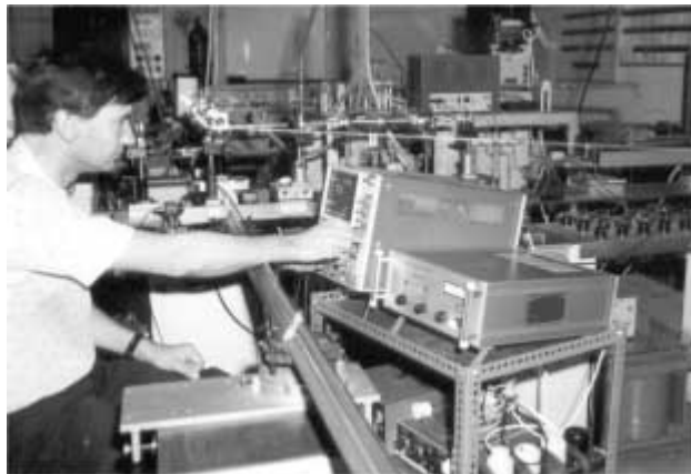
5. ábra. A gázlézer laboratórium az 1980-as években. A képen János Mibály dolgozik az üreges katódú He–Kr + lézerrel.
