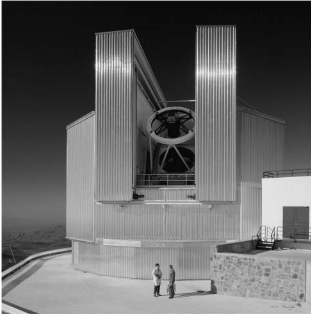
3. ábra. Az ESO 3,6 méteres New Technology Telescope elnevezésű távcsöve a jellegzetes nyolcszög alaprajzú fémházában. Forrás: ESO/C. Madsen
