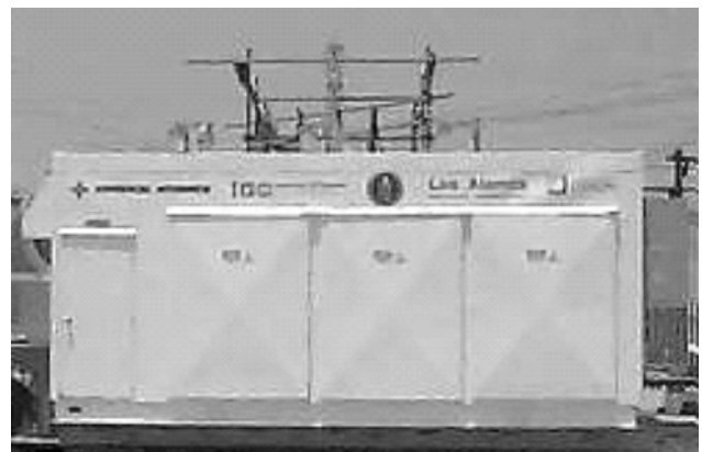
4. ábra. A General Atomics/Intermagetics áramkorlátozója MHS szupravezetővel a Southern California Edison alállomásán üzembe helyezve
