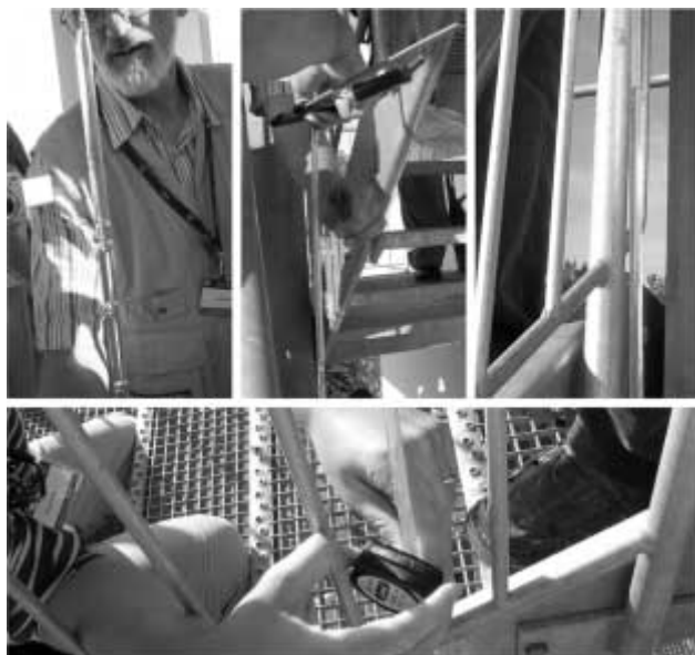
4. ábra. Mérés a 38-as épület tűzlépcsőjén
