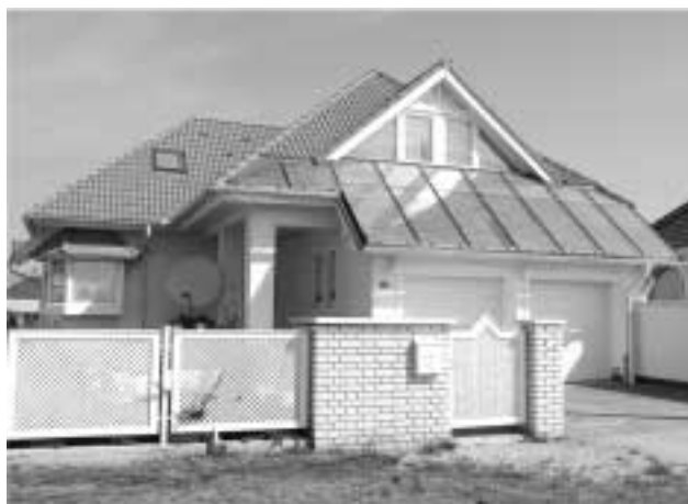
5. ábra. Napkollektor az egyik csepregi családi házon
