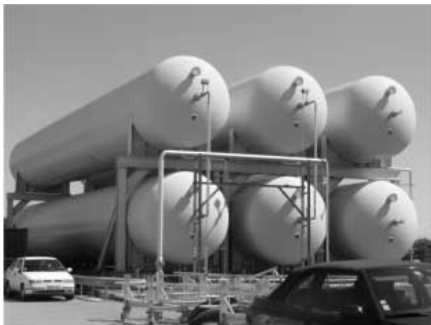
Óriási héliumtartályok a CMS-kísérlet telephelyén
