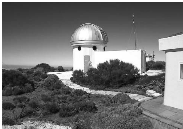
5. ábra. Pillanatkép a tenerifei SONG távcsövet mutató webkamera felvételéből. A spektrográf a távcsőtől külön, a kupolához kapcsolódó kiszolgálóépületben kapott helyet. A robottávcsőnek saját meteorológiai műszerei is vannak az épületen álló árbocon elhelyezve.
