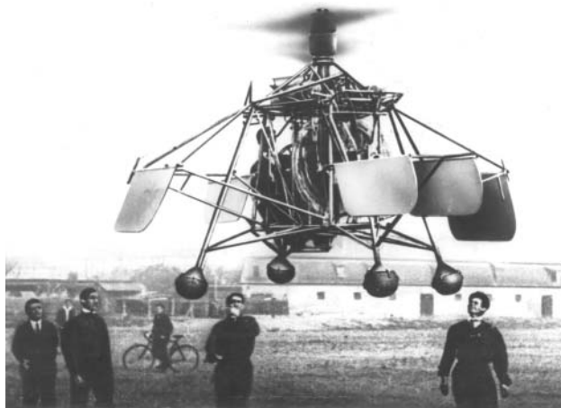
4. ábra. Kármán Tódor és Zsurovecz Vilmos Fischamendben a Petróczy István parancsnoksága alatt működő fejlesztő részlegben kifejlesztették a világon az első „kötött helikoptert”, a PKZ-helikoptert, amely tüzérségi megfigyelés céljaira szolgált. Az egyik első kísérlet (felül) és emberrel végrehajtott felszállás (alul).
