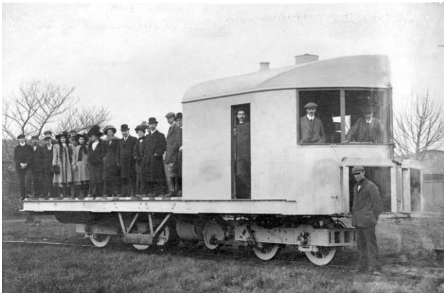
15. ábra. Brennan pörgettyűvel stabilizált egysínű vasútnak bemutatója (1910).
