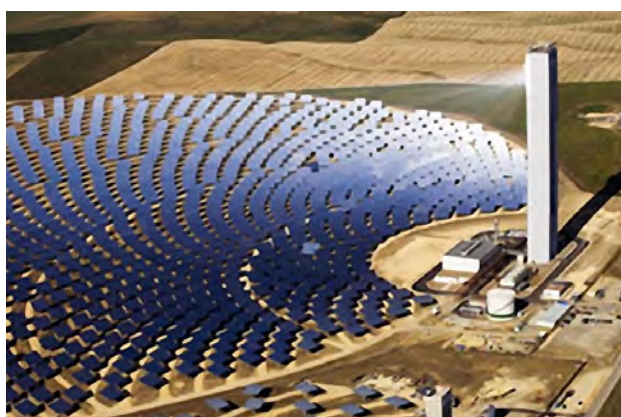
6. ábra. Napelemfarm (balra) és koncentrált naphőerőmű generátoros villamosenergia termeléshez (jobbra)
