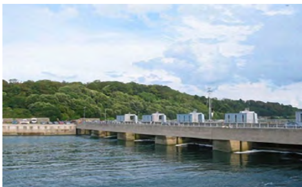
8. ábra. A Rance árapályerőmű 240 MW (balra). A vízerőmű sémája (jobbra)
