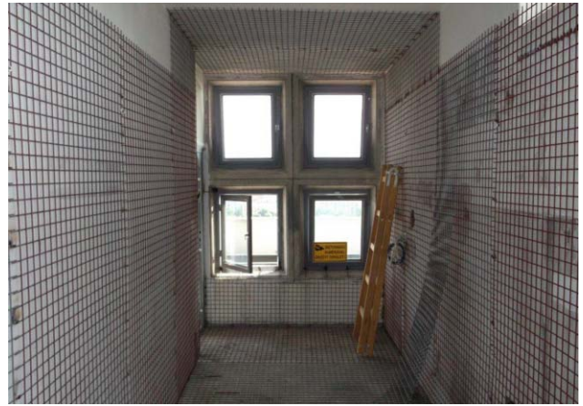
4. ábra. A vezérlőállomást védő Faraday-kalitka építése [1].
